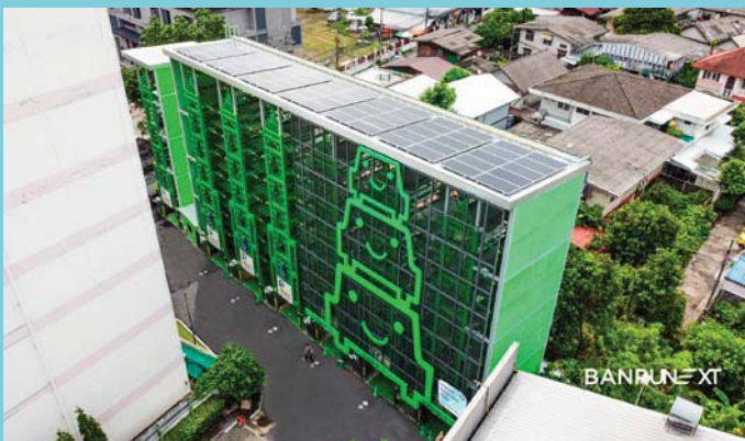
ที่จอดรถ Park2Go สาขา ลา วิลล่า อารีย์ หนึ่งในธุรกิจของ บริษัท ปาร์คพลัส จำกัด ที่จอดรถอัตโนมัติแนวตั้ง พร้อมระบบพลังงานแสงอาทิตย์ด้านบน
